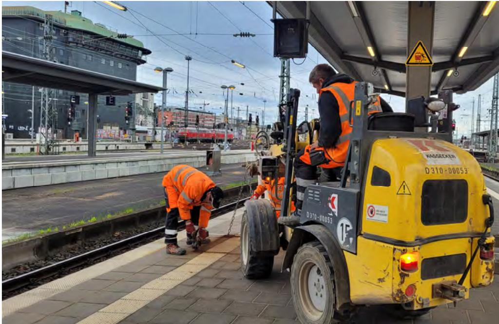
Parallel zur Planung werden vor Ort **Suchschachtungen** durchgeführt, um **Kollisionen** bei der herzustellenden Gründung mit vorhandenen Wasser- oder Kabelleitungen zu vermeiden. Zudem wurden auf den Personen- sowie Versorgungsbahnsteigen **Schachtdeckel als Vorabmaßnahme** geöffnet.
